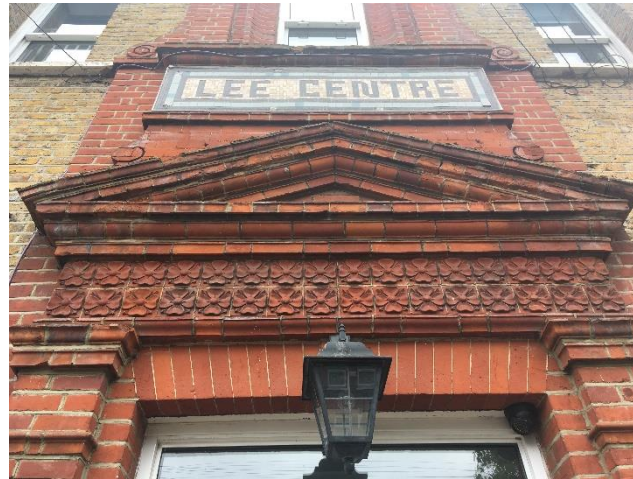
Lee Centre, Aislibie Road
